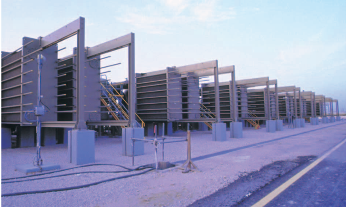
LNG (Ras Laffan, Qatar / UX-130, 16units)
